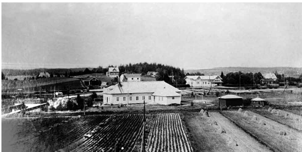
Skyddskårshuset (Marthagården) i Esbo centrum. Esbo Marthaförening övertog huset år 1944 och sålde det till Lindholms Såg 1949
