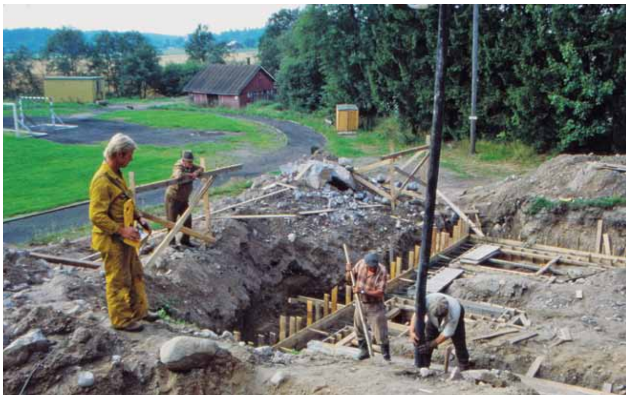
Fallåker klubblokals tillbygge, grunden gjuts år 1979. Foto: Tage Strandström.
