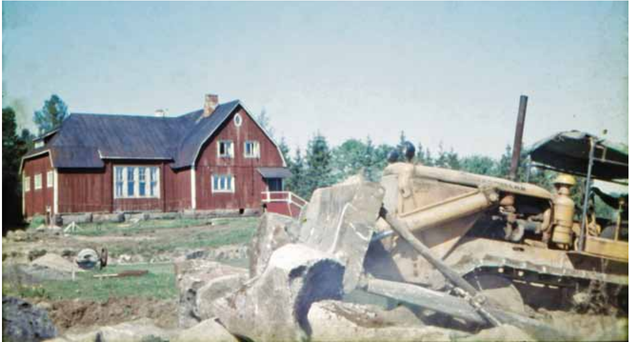
Fallåkerplanen under byggnad i mitten på 1950-talet. Foto: Tage Strandström.
